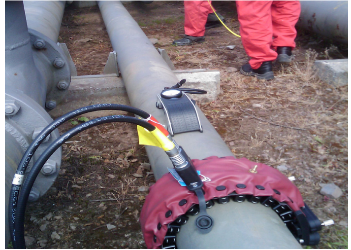
Vista de la línea inspeccionada en dirección negativa.
